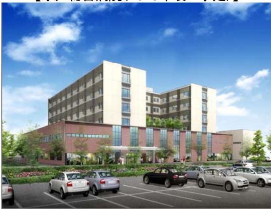
【水戸総合病院(2010年竣工予定)】
