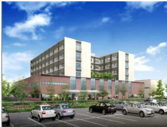
【ひたちなか総合病院(2010年竣工)】
